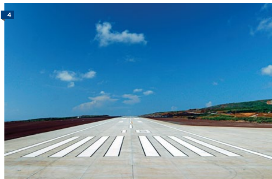
1. Aeropuerto, Cancún, Quintana Roo. 2. Carretera, Guadalajara - Tepic. 3. Pavimento Urbano, Los Cabos, Baja California Sur. 4. Pista Aérea.
