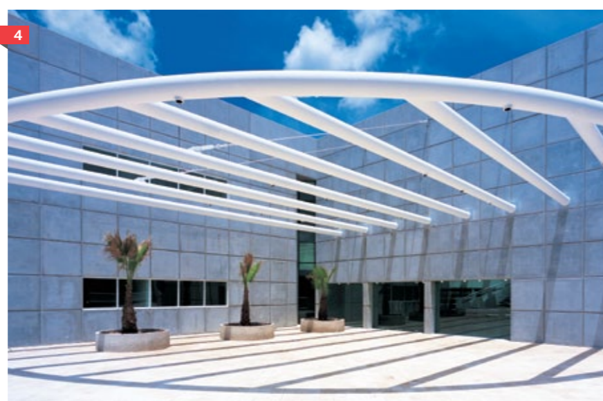
1. Sonoran Sea Resort, Puerto Peñasco, Sonora. 2. Gran Telescopio Milimétrico, Cerro de la Negra, Puebla. 3. Planta de Tratamiento de Aguas Negras, Ensenada, Baja California. 4. Empacadora Dorantes, Mérida, Yucatán.
