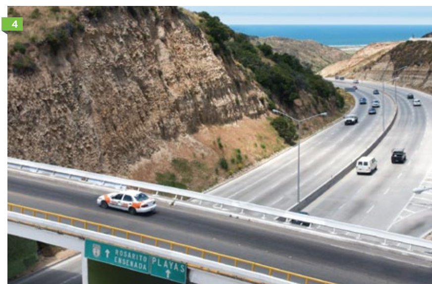
1. Colinas del Sol. 2. Aplicación de Relleno Fluido. 3. Construcción Sub-base para Pavimentos. 4. Base Pavimentación Tijuana, B.C.
