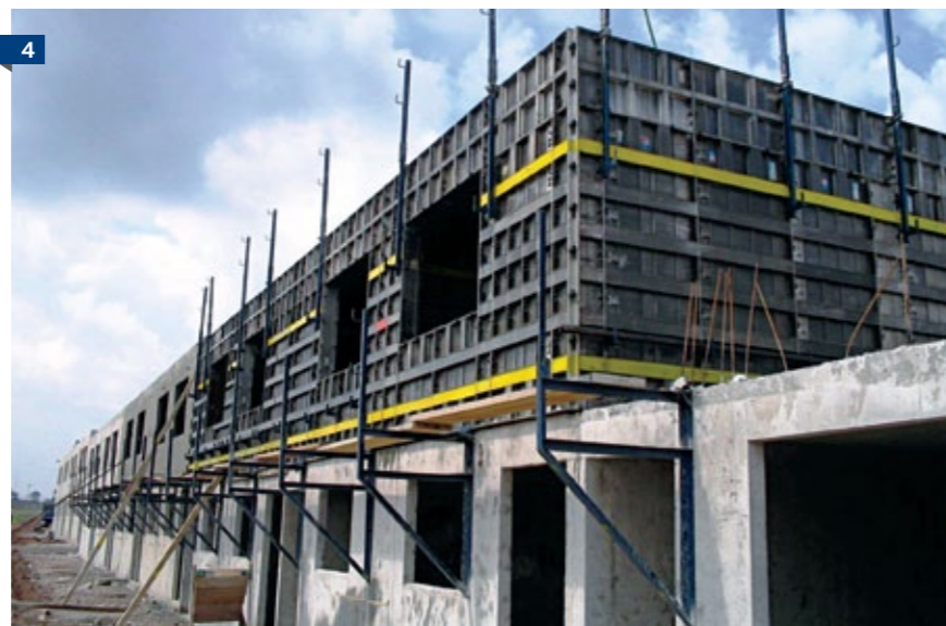
1. Elementos de forma irregular 2. Construcción de Vivienda, Monterrey, Nuevo León. 3. Elementos con armado semi-denso 4. Moldes de Vivienda
